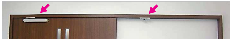
◆設置完了後の写真 ※部品の取付け位置
