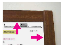
⇒ 物差しの100mm位置に合わせて、上枠にテープ等で目印をつける ⇒ 物差しを外す
