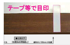
⇒ 物差しの100mm位置に合わせて、上枠にテープ等で目印をつける ⇒ 物差しを外す
