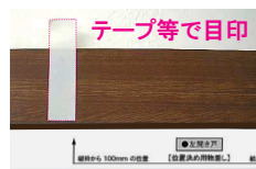
⇒ 物差しの100mm位置に合わせて、上枠にテープ等で目印をつける ⇒ 物差しを外す
