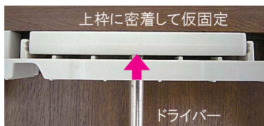
◆工具の穴にドライバーを挿入 ⇒ そのままドライバーで少し押し込めば、工具からベースが外れて上枠にくく仮固定>されます。
