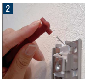
工具を使ってピンで仮固定する。
