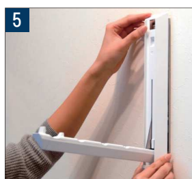
カバーを取付ける。
