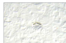
●取付け跡(実寸写真) ・切込み線状のネイル跡が残ります。 ・幅4mm程度なので、あまり目立ちません。
